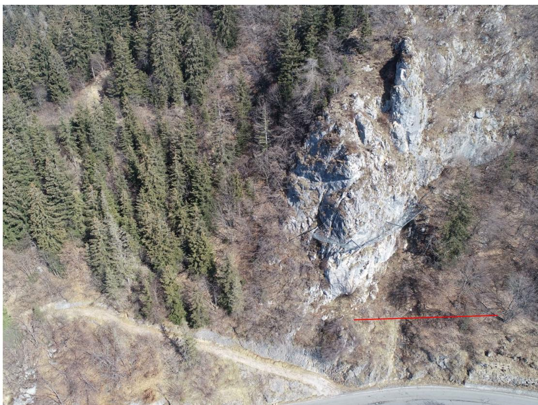
*Fotografia 1: Reti già posizionate, necessita un intervento di completamento con barriera paramassi*
