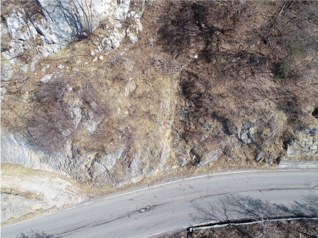
*Fotografia 2: Scivolamento di materiale detritico proveniente dall'erosione delle scarpate rocciose.*
